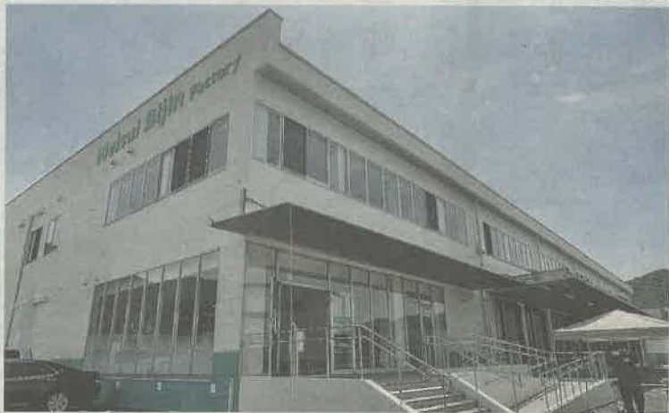
完成した岡山第3工場
